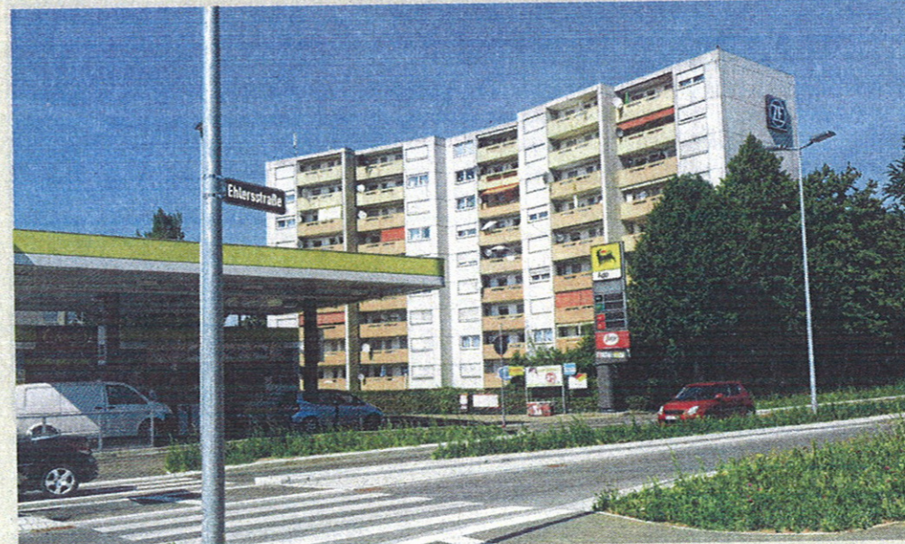
Das ZF-Hochhaus an der Ehlersstraße hat die Zeppelin Wohlfahrt 1972/73 gebaut.
